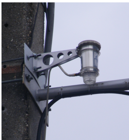
Slika 1– indikatori prolaska kvara sa detekcijom poremećaja električnog polja
