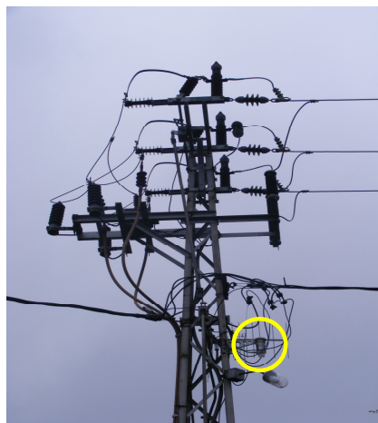
Slika 1– indikatori prolaska kvara sa detekcijom poremećaja električnog polja
