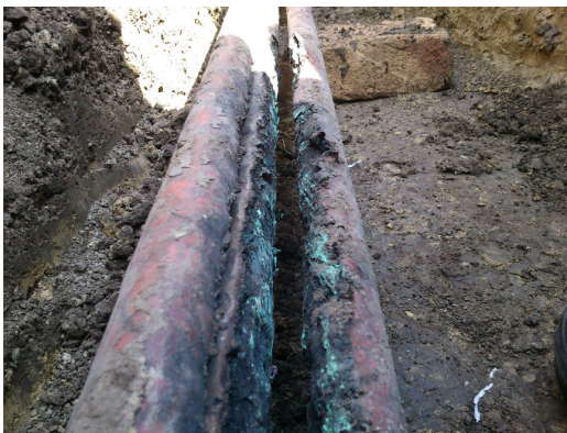
Slika 3- oštećenja na plaštu koji je u eksploataciji preko 30 godina
